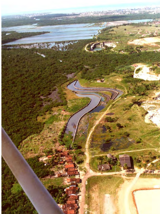
Figura 5.4: Vista Aérea dos Tanques do ESSE
