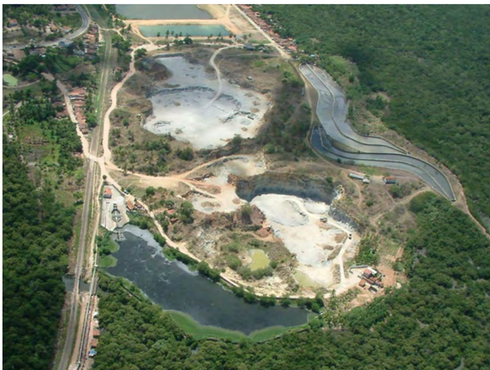
Figura 5.3: Vista Aérea do Polo de Tratamento de Esgotos do Baixo Paraíba, podendo observar os Tanques do S e a Pedreira nº 7 em funcionamento.
